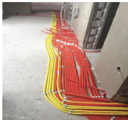
Elektro in vodovodna inštalacija, del plastičnih vodovodnih in elektro cevi v pritličju, marec 2018
