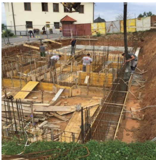
Opažanje za temelje in njihovo betoniranje, junij 2017
