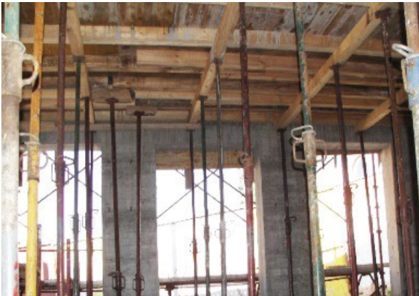
Opažanje in armiranje plošče za mansardo, avgust 2017
