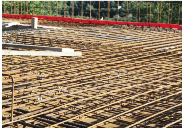
Opažanje in armiranje plošče za mansardo, avgust 2017
