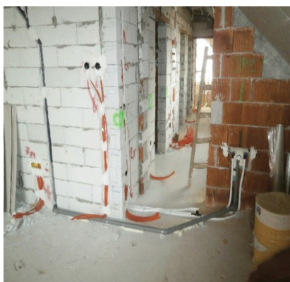
Elektro in vodovodna inštalacija, del plastičnih vodovodnih in elektro cevi v pritličju, marec 2018
