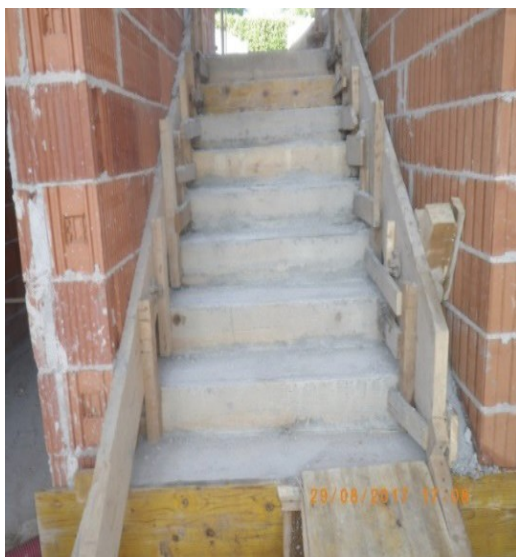
Betoniranje stopnišča, avgust 2017
