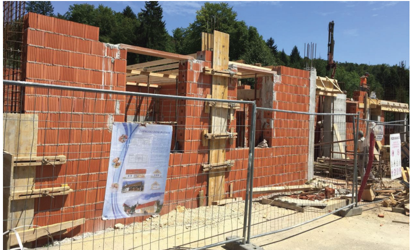
Zidanje obodnih zidov, julij 2017
