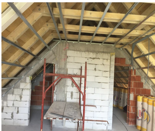
Nosilne letve za namestitev izolacije, oktober 2017
