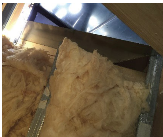
Nameščanje izolacije v mansardi, april 2018
