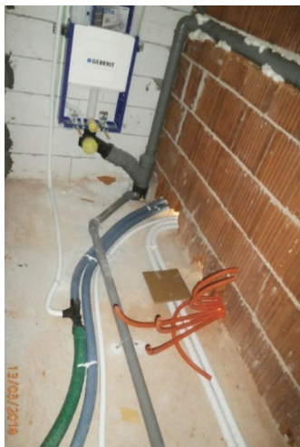
Razvod vode po toaletah in polaganje talnega ogrevanja, april 2018
