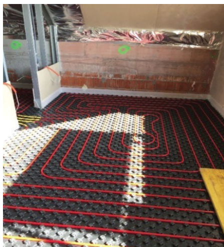
Razvod vode po toaletah in polaganje talnega ogrevanja, april 2018
