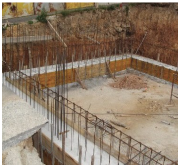
Opažanje za temelje in njihovo betoniranje, junij 2017
