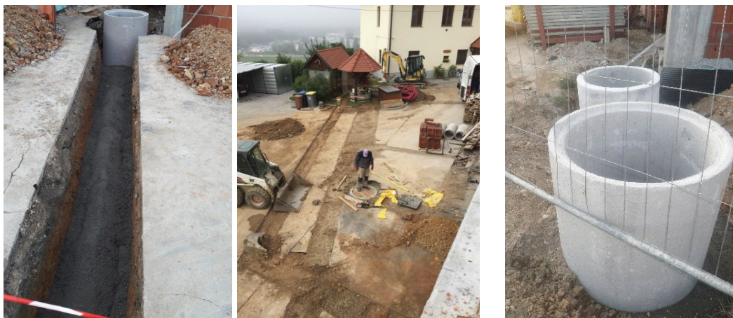
Izkop in zasutje kanalizacije ter peskolov na jugovzhodni strani, september 2017
