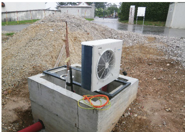
Montaža toplotne črpalke, maj 2018
