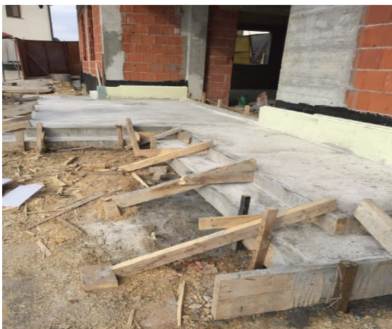
Betoniranje podesta, oktober 2017
