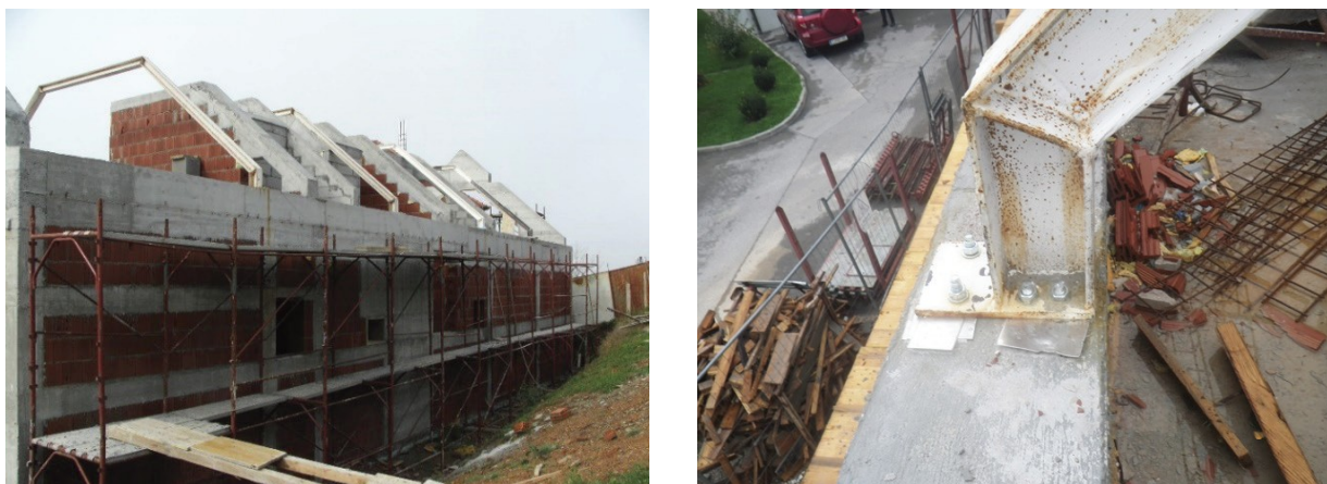
Kovinska konstrukcija za streho, september 2017
